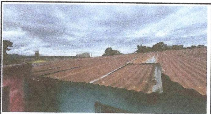
Foto 3: Sustitución de lámina, ppor lámina troqueiada aluzinc calibre 26 con color
