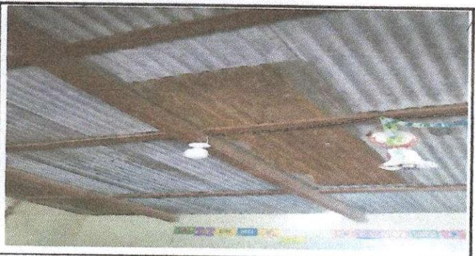
Foto 5: Sustitución de lámina, ppor lámina troqueiada aluzinc calibre 26 con color
