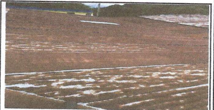
Foto 6: Sustitución de lámina, ppor lámina troqueiada aluzinc calibre 26 con color
